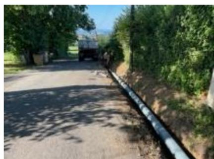
Afin de protéger la banquette de la route communale tout en sécurisant le croisement des véhicules, des travaux de drainage des eaux pluviales ont été réalisés
