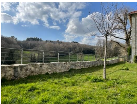
l'ensemble des éléments ont été thermolaqués.
